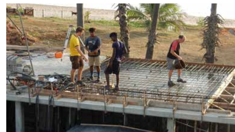
CCS – Bau des Mitarbeitergebäudes
